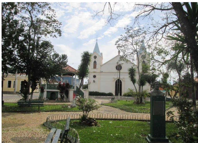
Figura 6.4 – Igreja Bom Jesus da Pedra Fria
