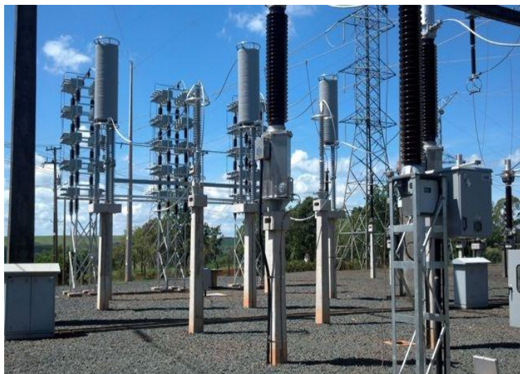
Figura 3.6 – Subestação da COPEL em Jaguariaíva
