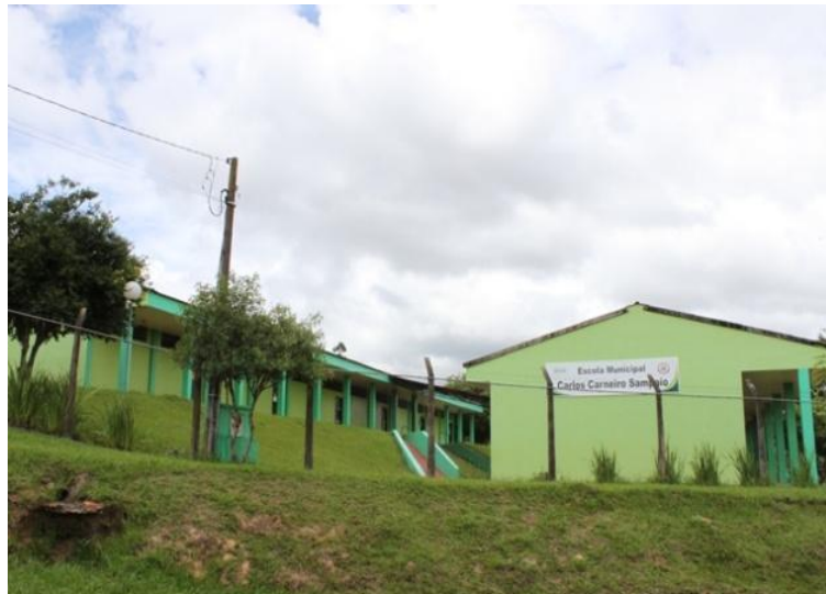
Figura 8.18 – Escola Municipal Carlos Carneiro Sampaio
