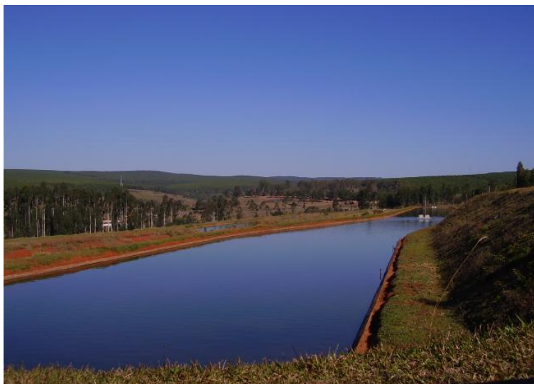
Figura 4.3 – Estação de Tratamento de Esgoto (ETE)
