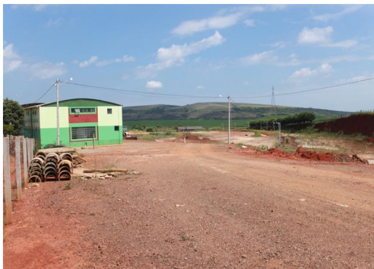
Figura 4.4 – Aterro Sanitário de Jaguariaíva
