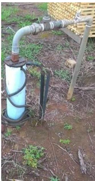
Figura 04 - Captação em poço profundo - Distrito Industrial II
