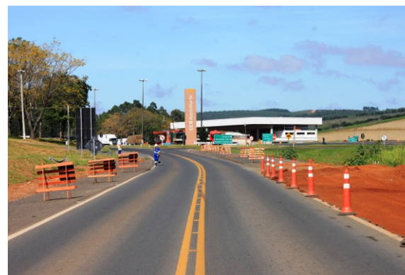
Entroncamento das rodovias PR-151 e PR-092
