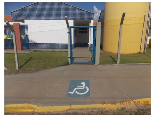
Rebaixamento de guia
