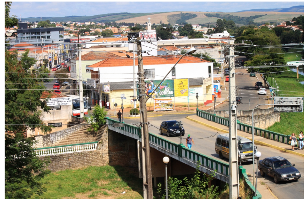
Ponte sobre o Rio Capivari
