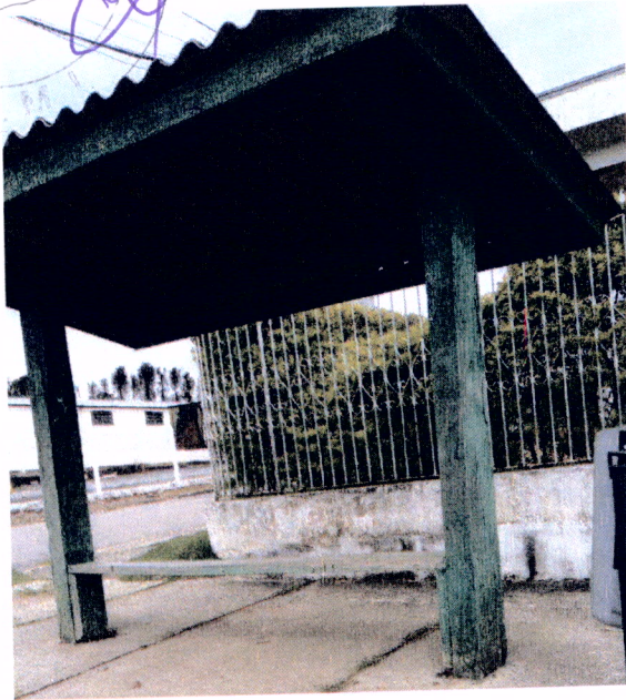
Figura 21: PED no bairro Vila Pinheiro (1)
