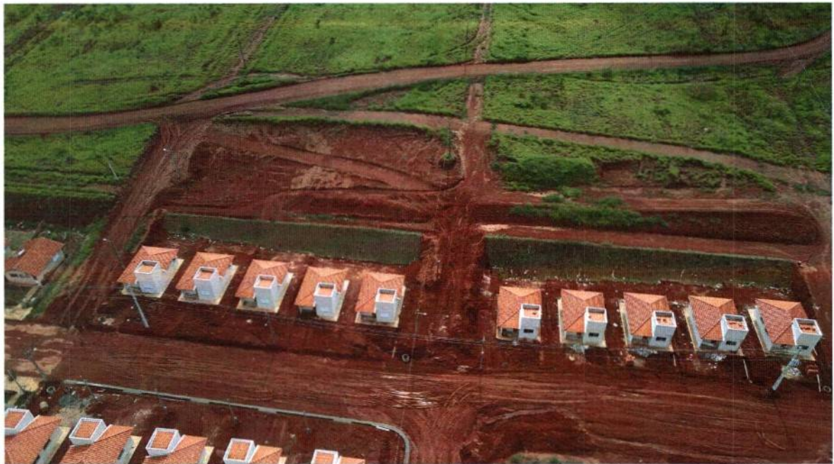
Imagem 18: Fiscalização por drone realizada em 12 de janeiro de 2023
