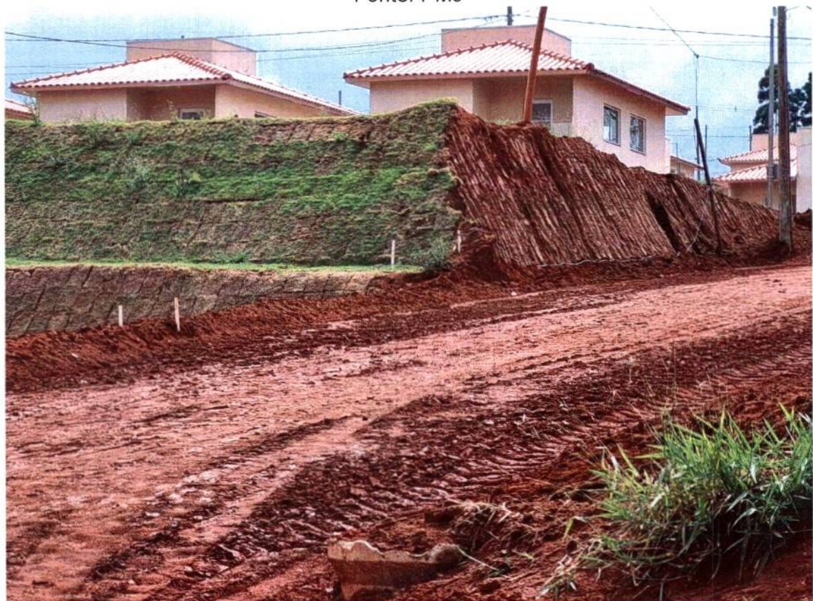
Imagem 19: Fiscalização realizada em 12 de janeiro de 2023 Fonte: PMJ
