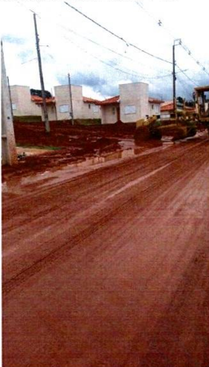
Imagem 4: Contaminação da Rua Capitão Aviador João Igor Silva Pivovar com terras deslizadas pela terraplanagem e período de chuvas sem a devida contenção temporária destas terras. Fonte: PMJ
