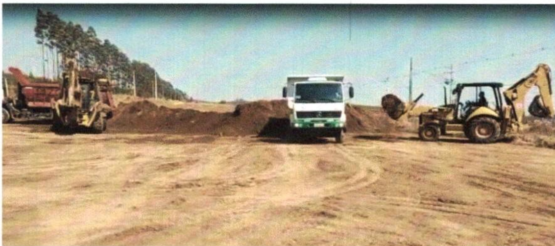
Imagem 01 – Maquinário da Prefeitura fazendo o recolhimento da camada vegetal para o envio ao aterro municipal, a pedido da prefeitura e secretário.
