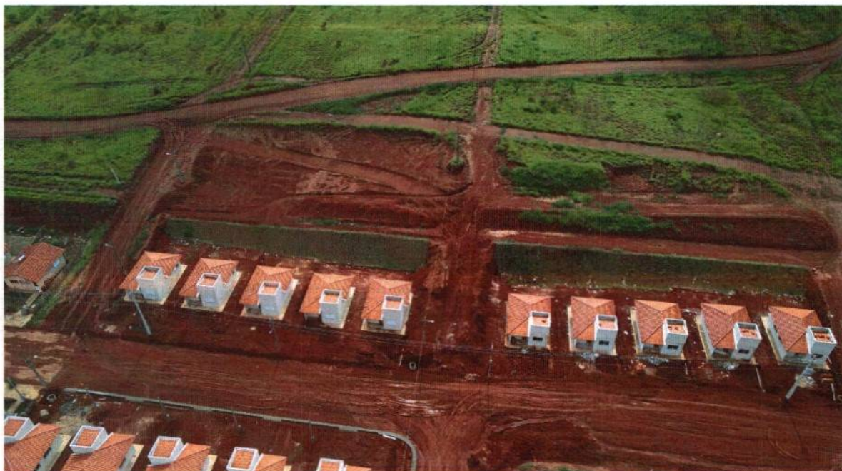
Imagem 18: Fiscalização por drone realizada em 12 de janeiro de 2023 Fonte: PMJ
