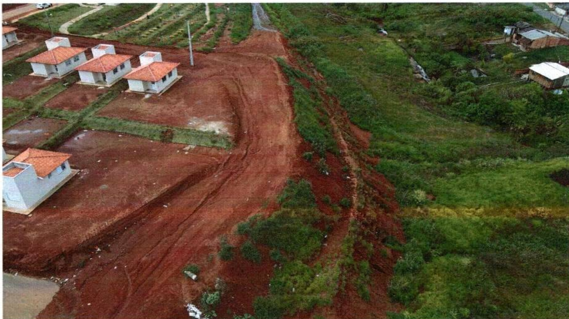
Imagem 16: Fiscalização por drone realizada em 12 de janeiro de 2023 Fonte: PMJ
