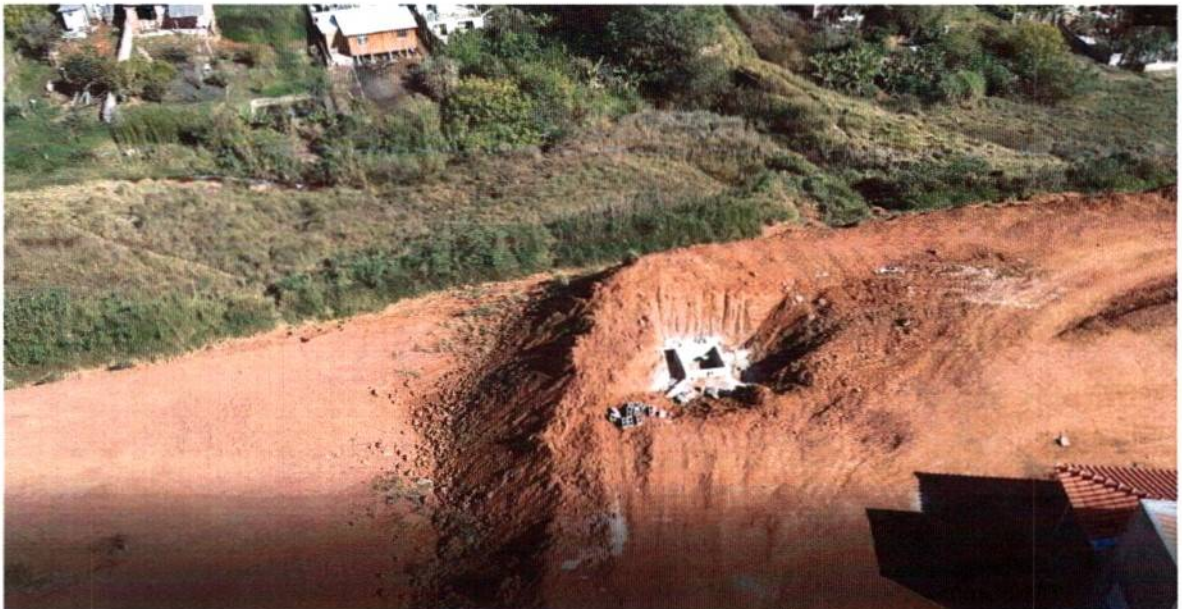
Imagem 11: Fiscalização por drone realizada em 27 de julho de 2022 Fonte: PMJ
