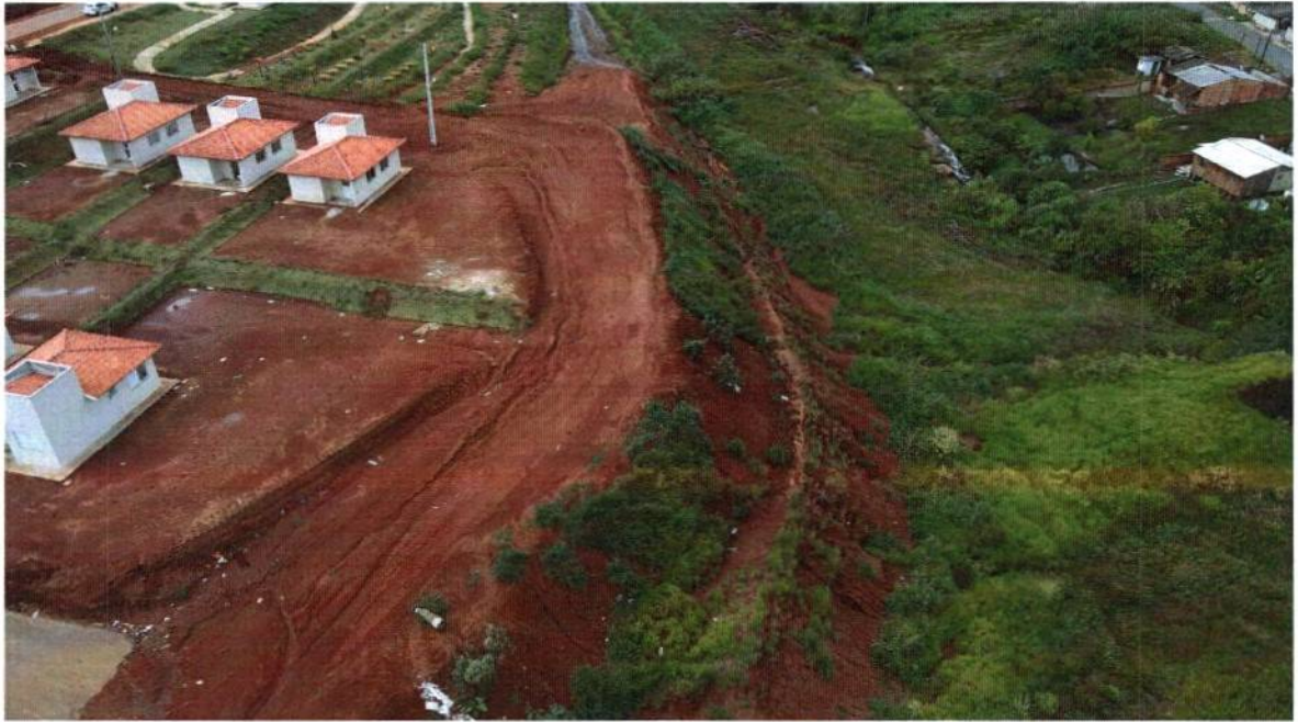
Imagem 16: Fiscalização por drone realizada em 12 de janeiro de 2023
