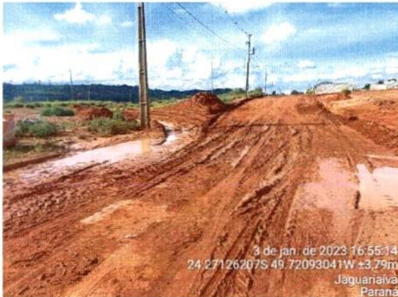
Imagem 3: Maquinário e operações de limpeza realizadas pela Prefeitura. Fonte: PMJ
