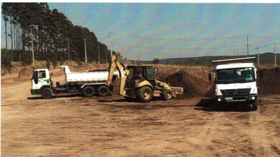
Imagem 02 – Maquinário da Prefeitura fazendo o recolhimento da camada vegetal para o envio ao aterro municipal, a pedido da prefeitura e secretário.
