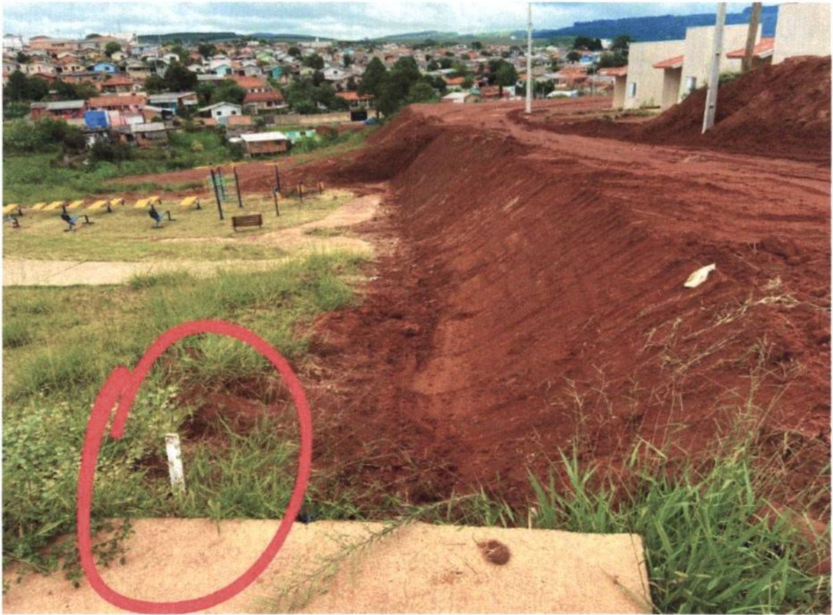
Imagem 10: Marcação de limite da praça, a terra não está invadindo. Como a praça será aterrada, sanaremos tal problema.
