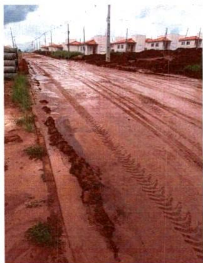
Imagem 2: Contaminação da Rua Capitão Aviador João Igor Silva Pivovar com terras deslizadas pela terraplanagem e período de chuvas sem a devida contenção temporária destas terras. Fonte: PMJ
