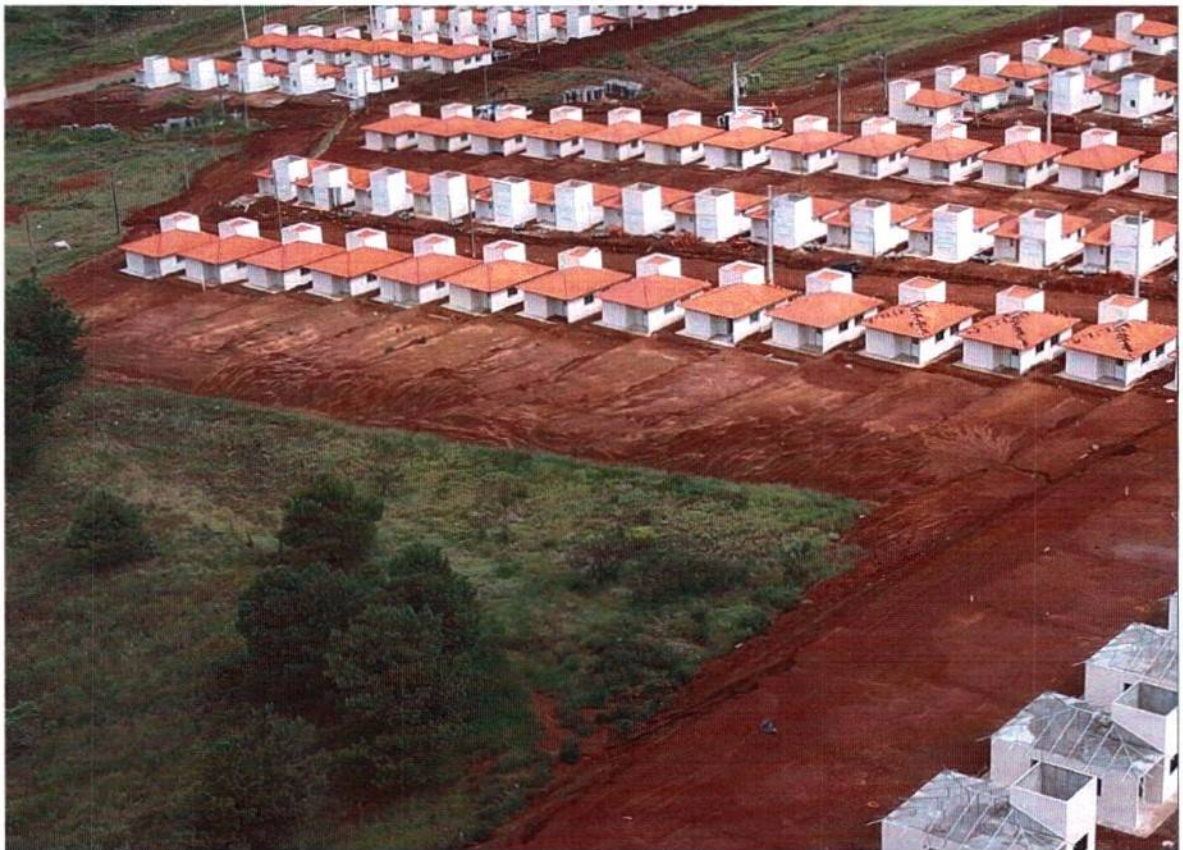
Imagem 17: Fiscalização por drone realizada em 12 de janeiro de 2023
