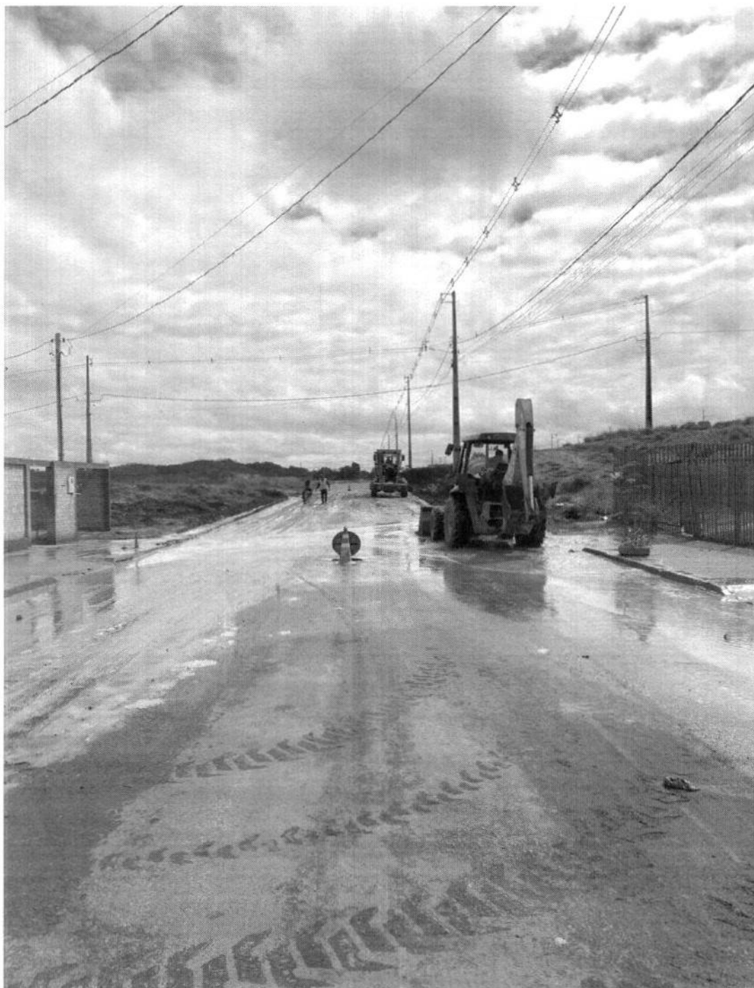
Imagem 09: Desobstrução de PV de drenagem e bocas de lobo no dia 15/09/2022, onde os moradores de Araponga e Rouxinol pediram ajuda para a empresa Pizolato pois a água das chuvas dos terrenos pertencentes ao município obstruíram com barro a rede de drenagem. o município deve verificar sobre a inclusão de cobertura com camada vegetal afim de minimizar os danos causados a empreendimentos que não são de responsabilidade da empresa Pizolato.
