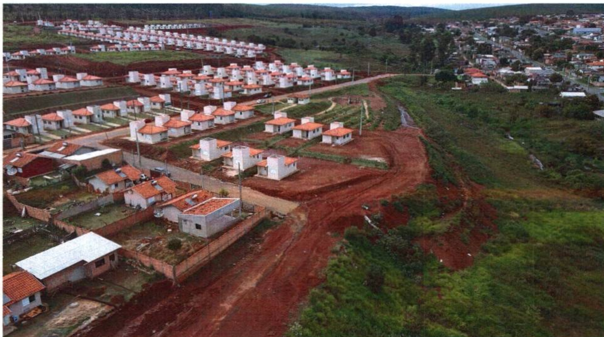
Imagem 14: Fiscalização por drone realizada em 12 de janeiro de 2023
