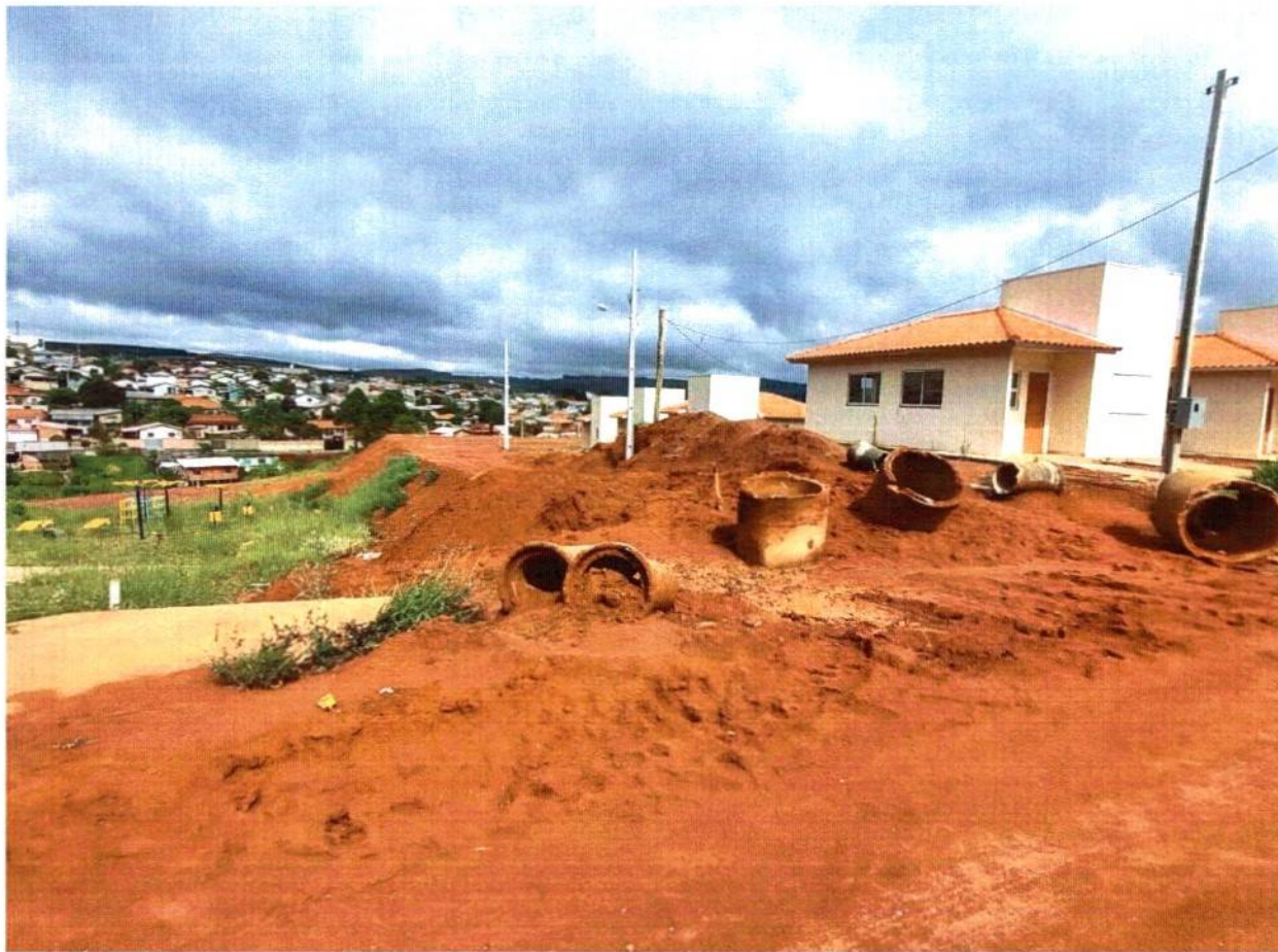
Imagem 20: Fiscalização realizada em 12 de janeiro de 2023
