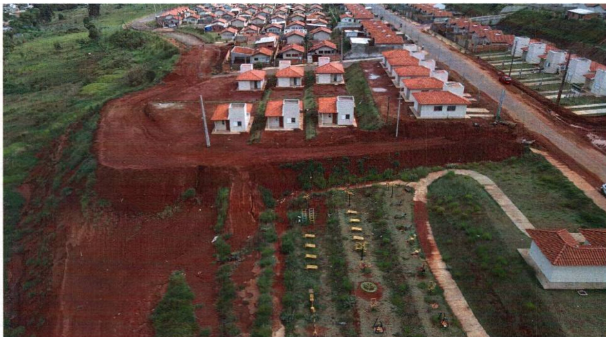
Imagem 15: Fiscalização por drone realizada em 12 de janeiro de 2023
