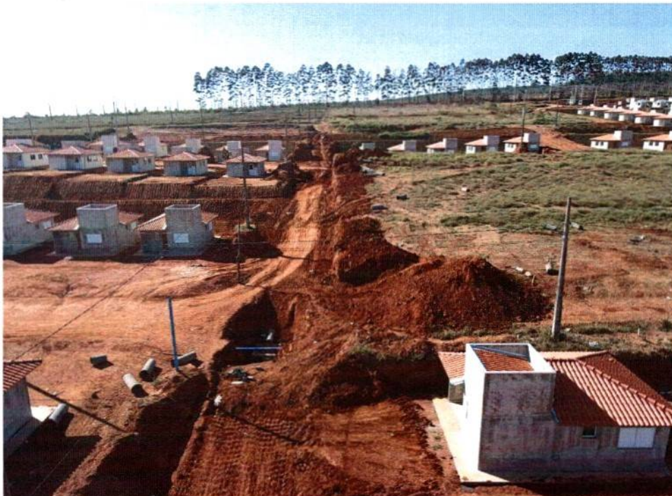
Imagem 9: Fiscalização por drone realizada em 27 de julho de 2022 Fonte: PMJ
