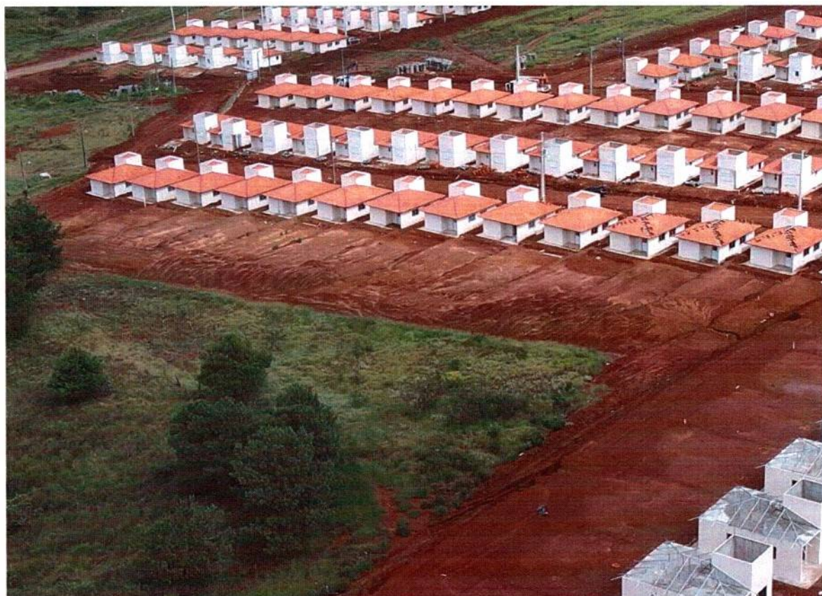
Imagem 17: Fiscalização por drone realizada em 12 de janeiro de 2023 Fonte: PMJ
