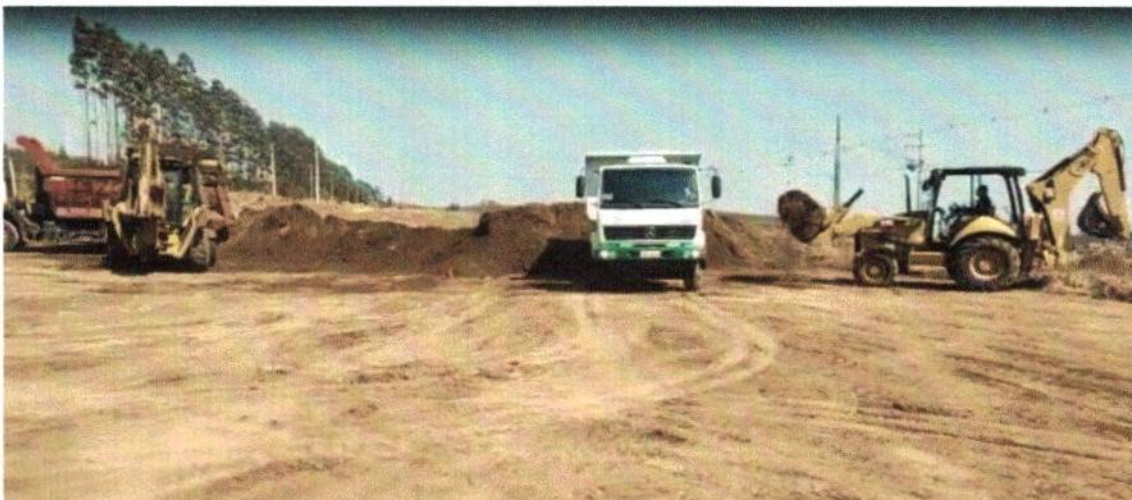
Imagem 01 – Maquinário da Prefeitura fazendo o recolhimento da camada vegetal para o envio ao aterro municipal, a pedido da prefeitura e secretário.
