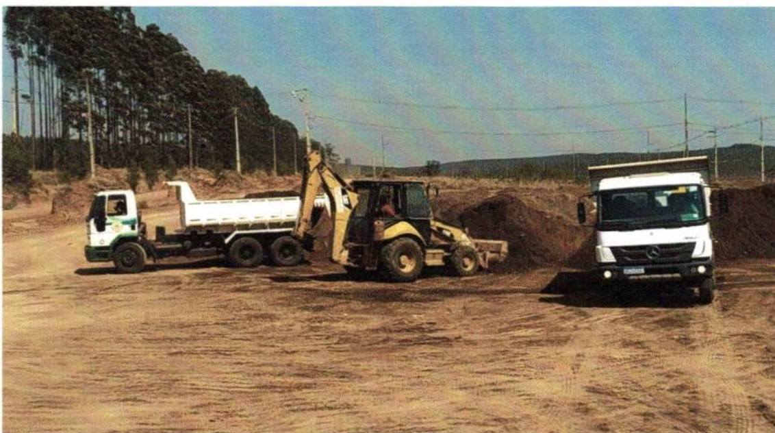
Imagem 02 – Maquinário da Prefeitura fazendo o recolhimento da camada vegetal para o envio ao aterro municipal, a pedido da prefeitura e secretário.
