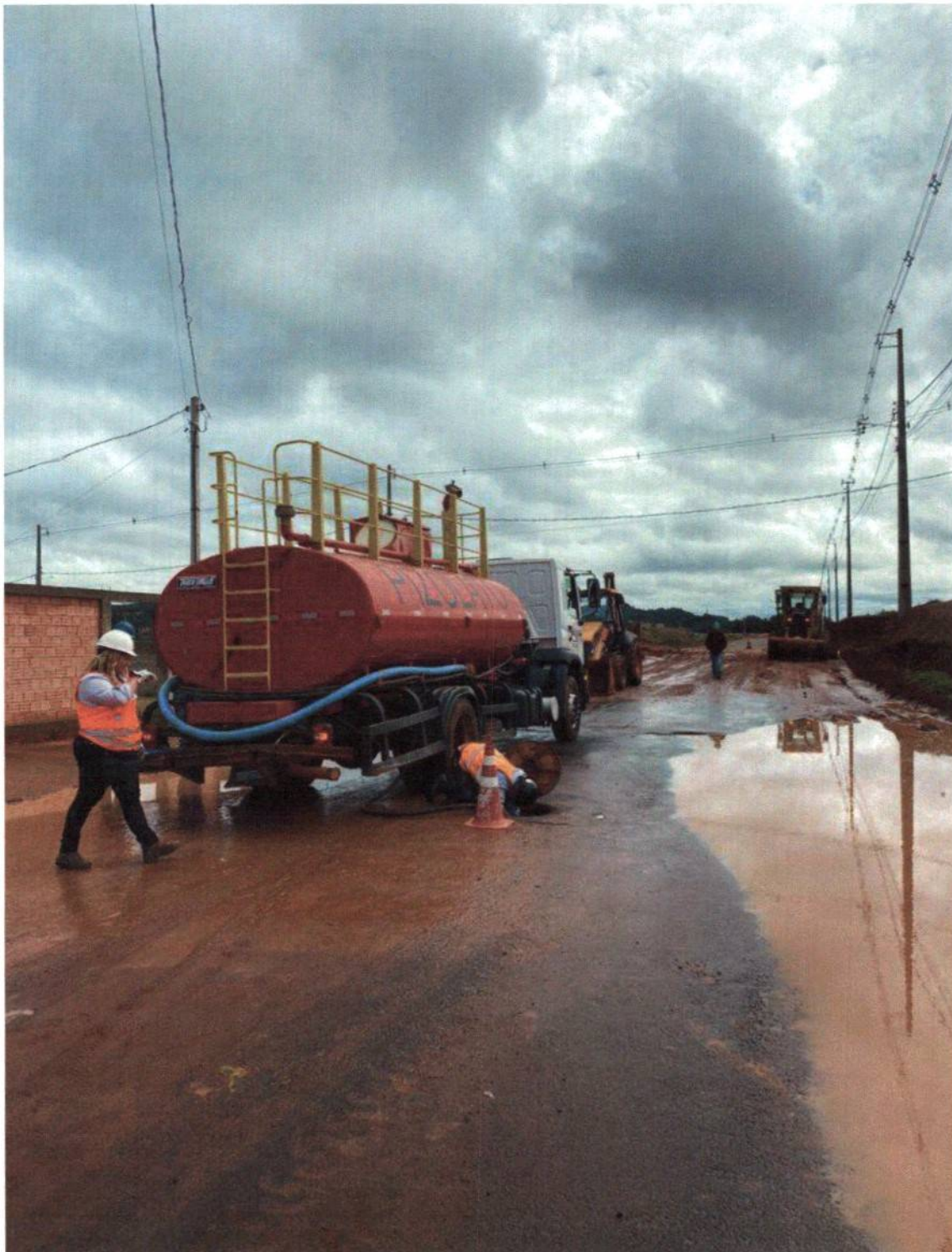
Imagem 06: Desobstrução de PV de drenagem e bocas de lobo no dia 15/09/2022, onde os moradores de Araonga e Rouxinol pediram ajuda para a empresa Pizolato pois a água das chuvas dos terrenos pertencentes ao município obstruíram com barro a rede de drenagem. o município deve verificar sobre a inclusão de cobertura com camada vegetal afim de minimizar os danos causados a empreendimentos que não são de responsabilidade da empresa Pizolato.
