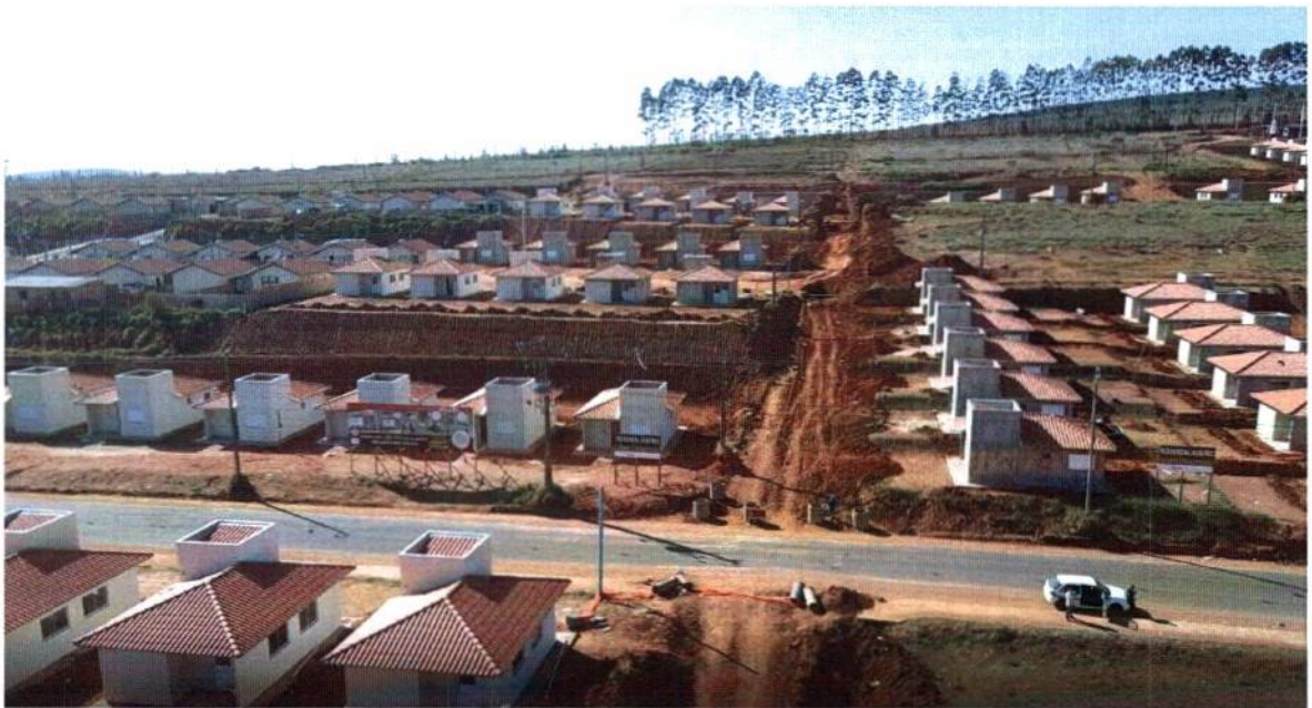
Imagem 10: Fiscalização por drone realizada em 27 de julho de 2022 Fonte: PMJ
