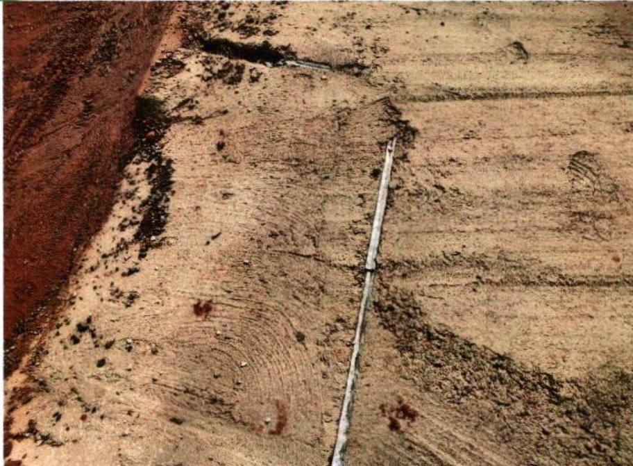
FOTO 19: CALÇADAS DANIFICADAS E NÃO ATENDEM CONDIÇÕES MÍNIMAS DE ACESSIBILIDADE, RAMPA DE ACESSIBILIDADE EM DESCONFORMIDADE COM NBR 9050
