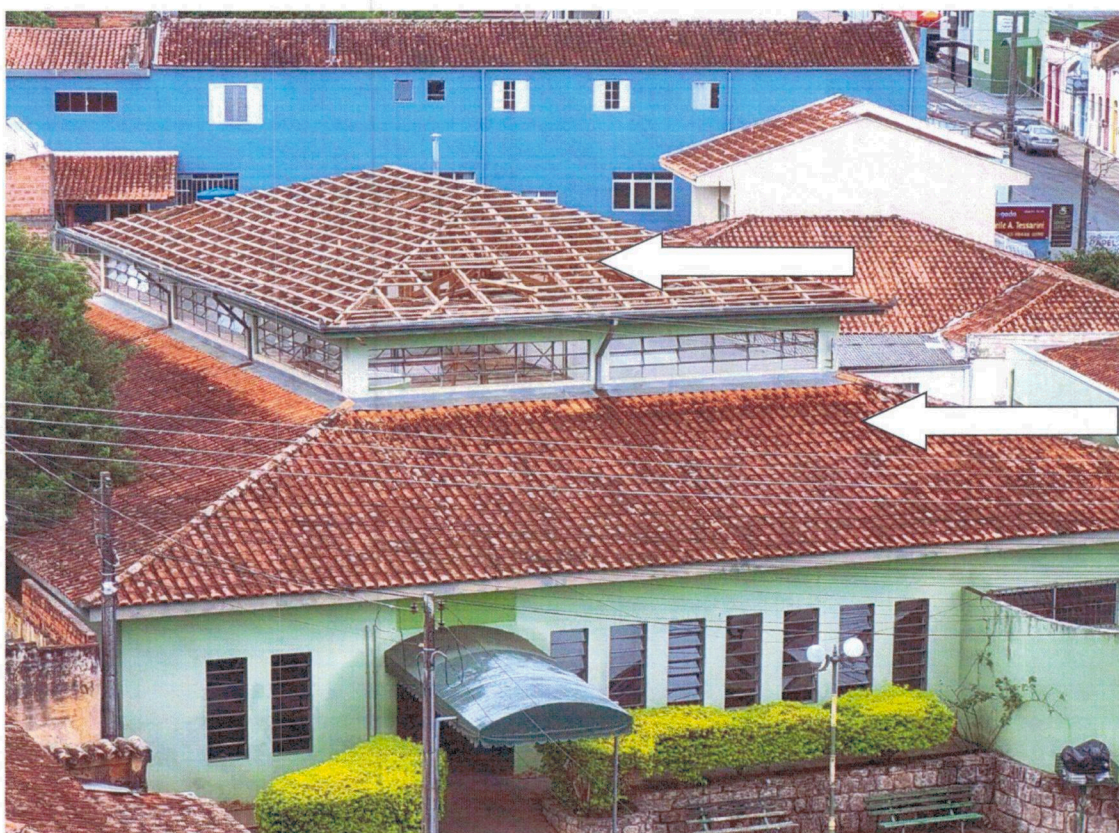
Figura 9 – telhados a remover
