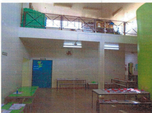
Figura 3 - condições da pintura interna
