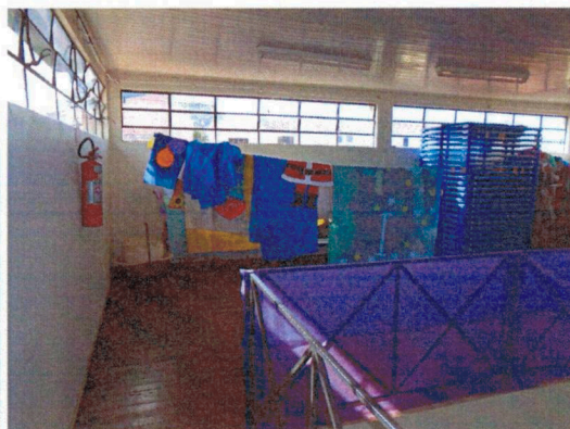
Figura 13 – remoção assoalho do mezanino
