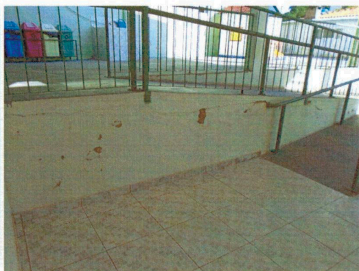
Figura 4 - condições da pintura interna
