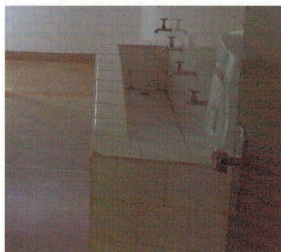
Figura 22 – demolição de tanque de alvenaria
