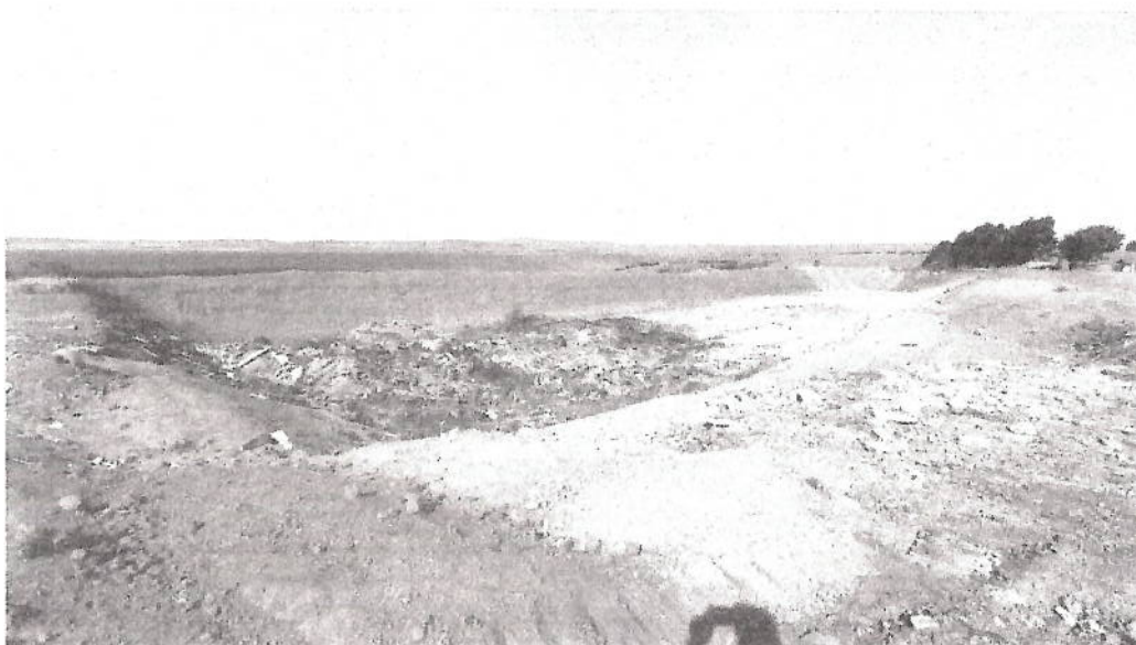
Foto 1 - Vala atual sendo utilizada sem a devida impermeabilização.
