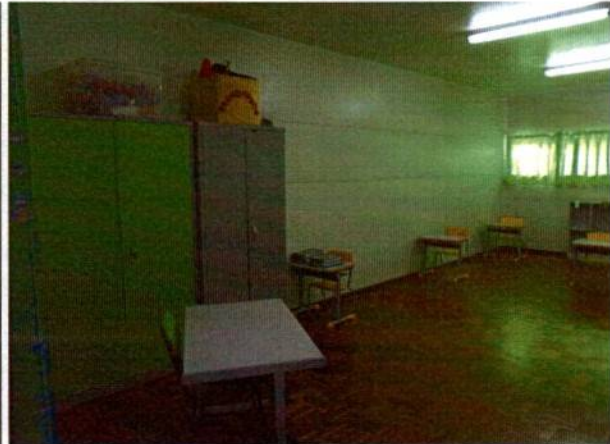
Figura 18 – remoção de tacos de madeira
