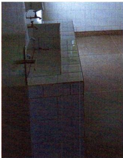
Figura 23 – demolição de tanque de alvenaria
