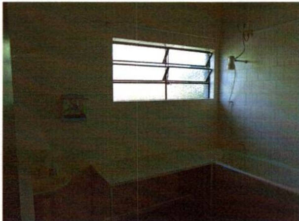
Figura 21 – demolição de tanque de alvenaria
