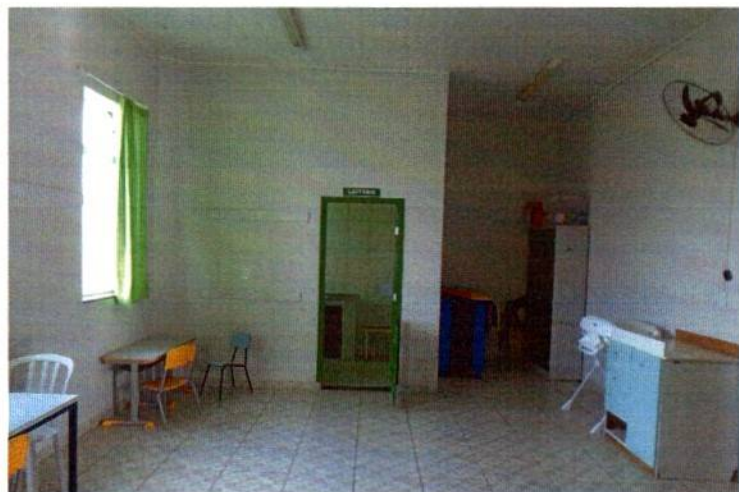
Figura 24 – fechamento de vão com parede de gesso acartonado
