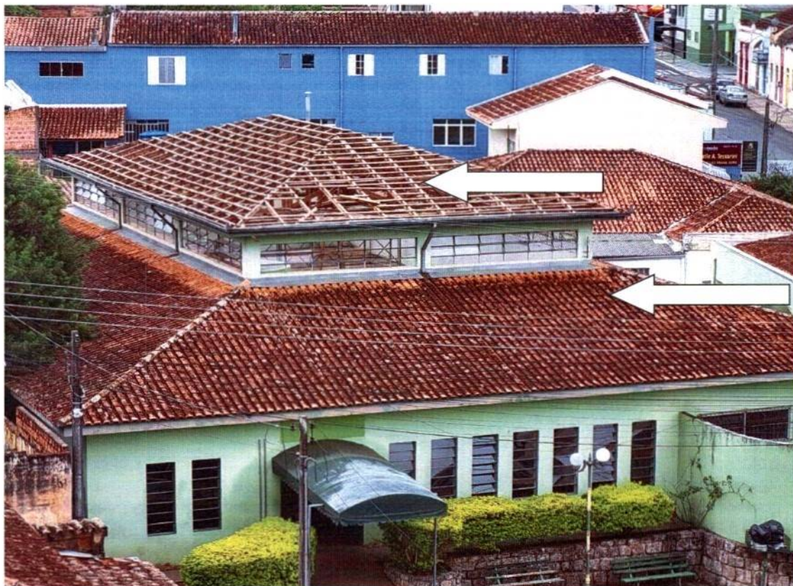
Figura 9 – telhados a remover
