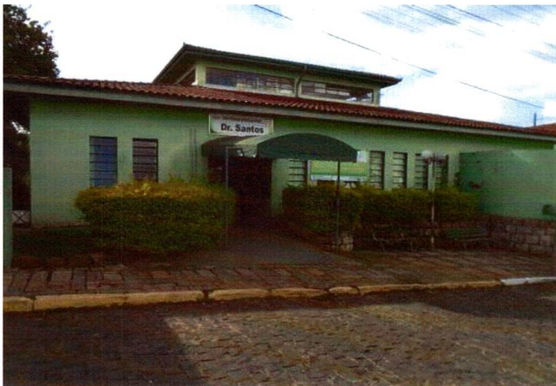
Elevação voltada para a Travessa Ulisses Santos Lima
