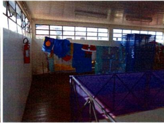
Figura 13 – remoção assoalho do mezanino
