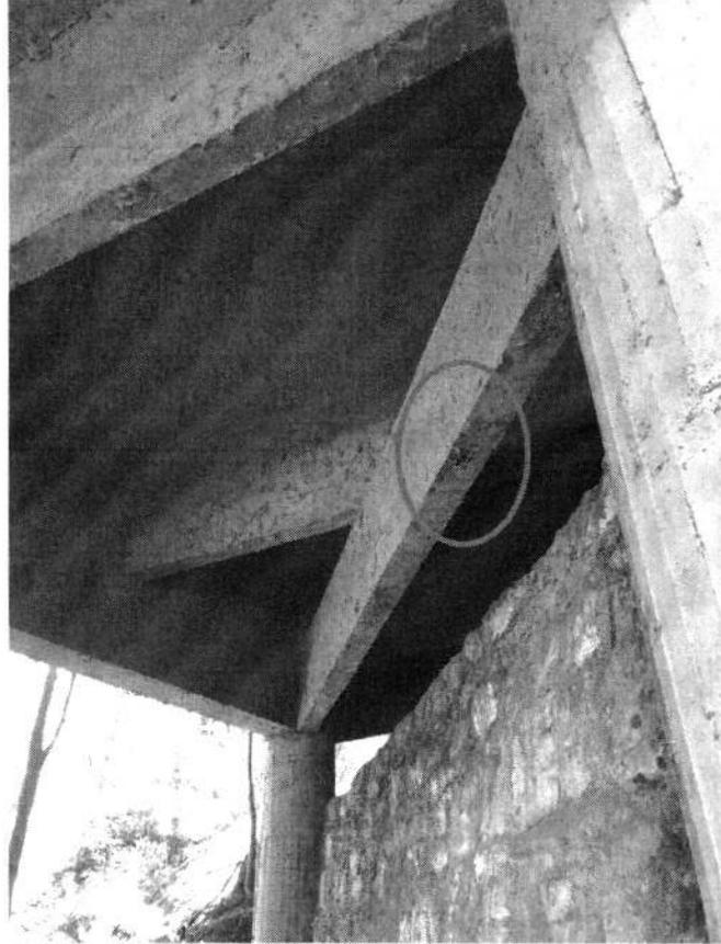
Figura 8 – Desplacamento de concreto
