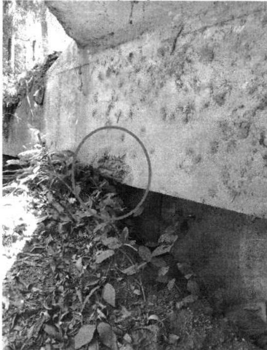
Figura 4 – Viga Transversa com fissuras e deslocamento de concreto.
