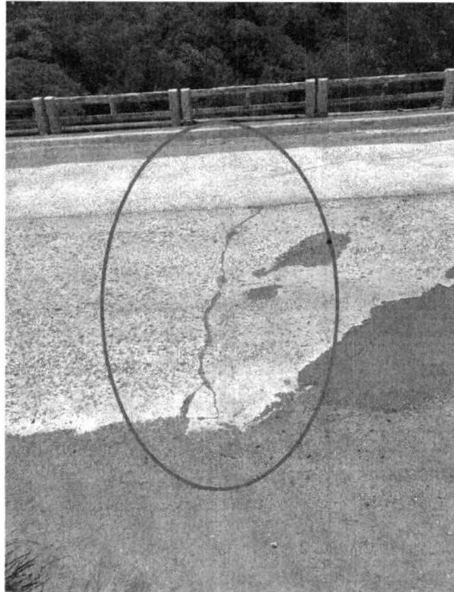
Figura 10 – Junta de dilatação encoberta por remendo de asfalto.
