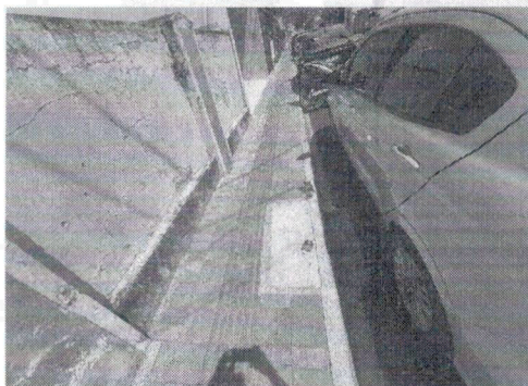
Foto 08: Vista da boca de lobo adicionada na Rua João Pessa
