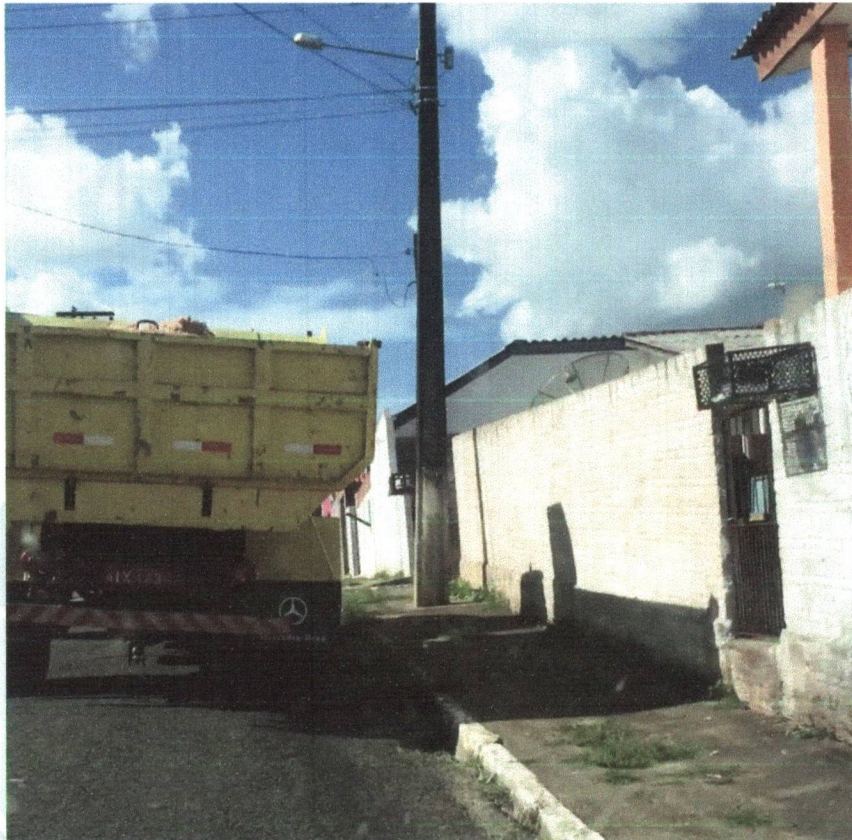
Rua Antônio Porfírio Alves - Trecho da estaca 1 e 2 do Projeto.
