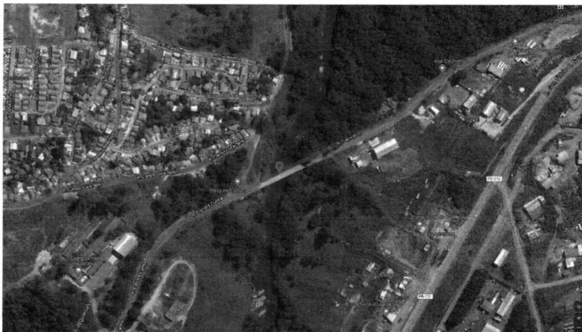
Figura 1: Local onde será implantada a Passarela de Pedrestes
