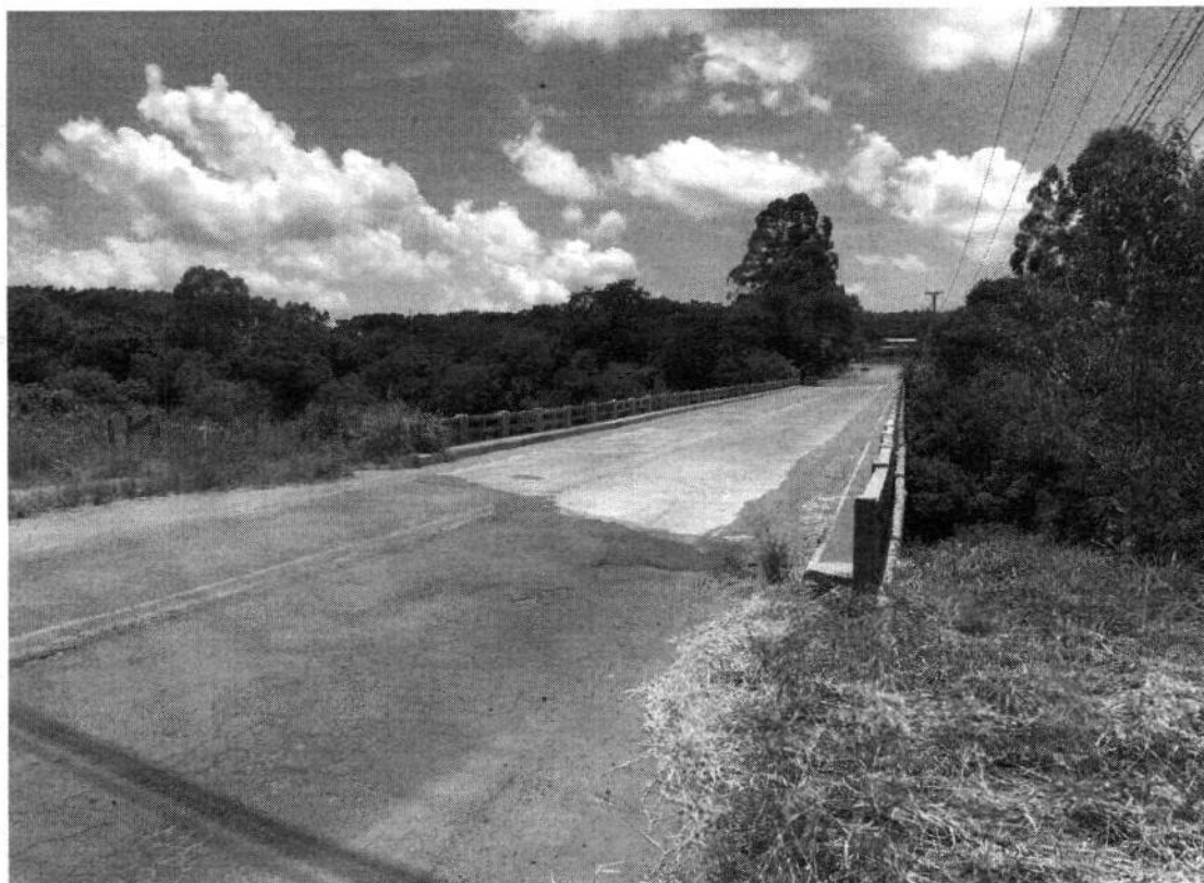
Figura 1: Ponte do Adão, rua Eurides Cunha.
