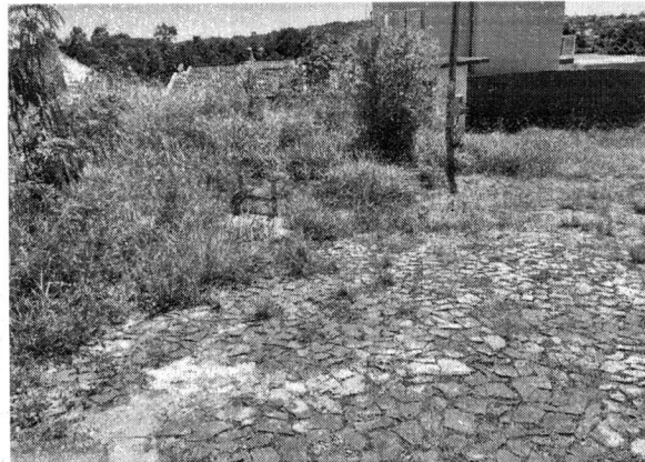
Figura 4 – foto da porção inferior direita com vistas para a edificação da SAMAE DATA: 03/04/2023.
