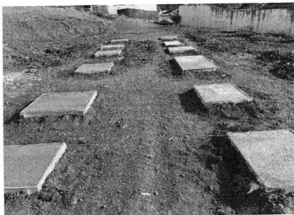
Figura 7 – Execução das bases da Academia pela prefeitura. DATA: 31/05/2023.
