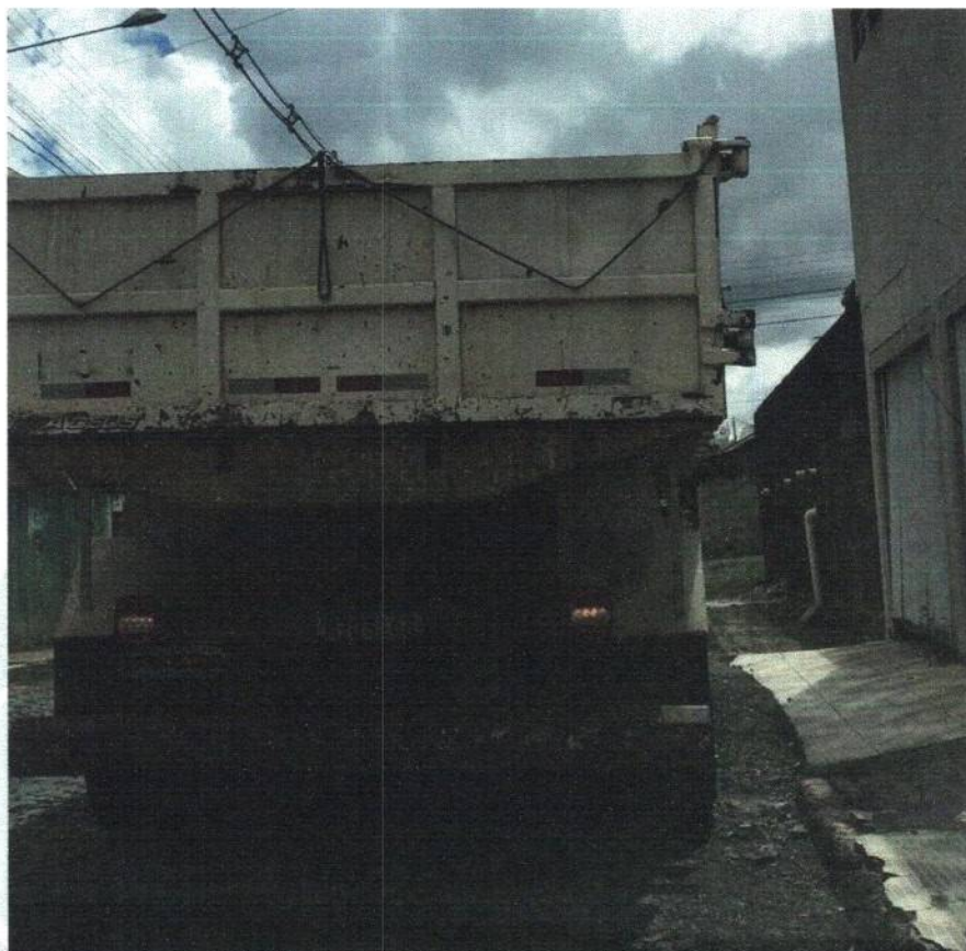
Rua das Rosas - Trecho da estaca 16 e 15 do Projeto.
