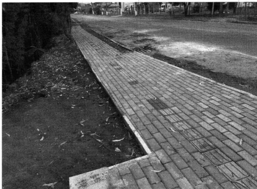
Figura 3 – Foto tirada no dia 03 de outubro mostrando a pavimentação executada.
