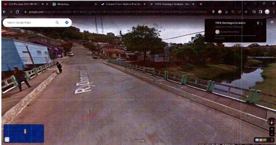
FOTO 11 Ponte de Acesso – Centro Belvedere (Vermelho)
