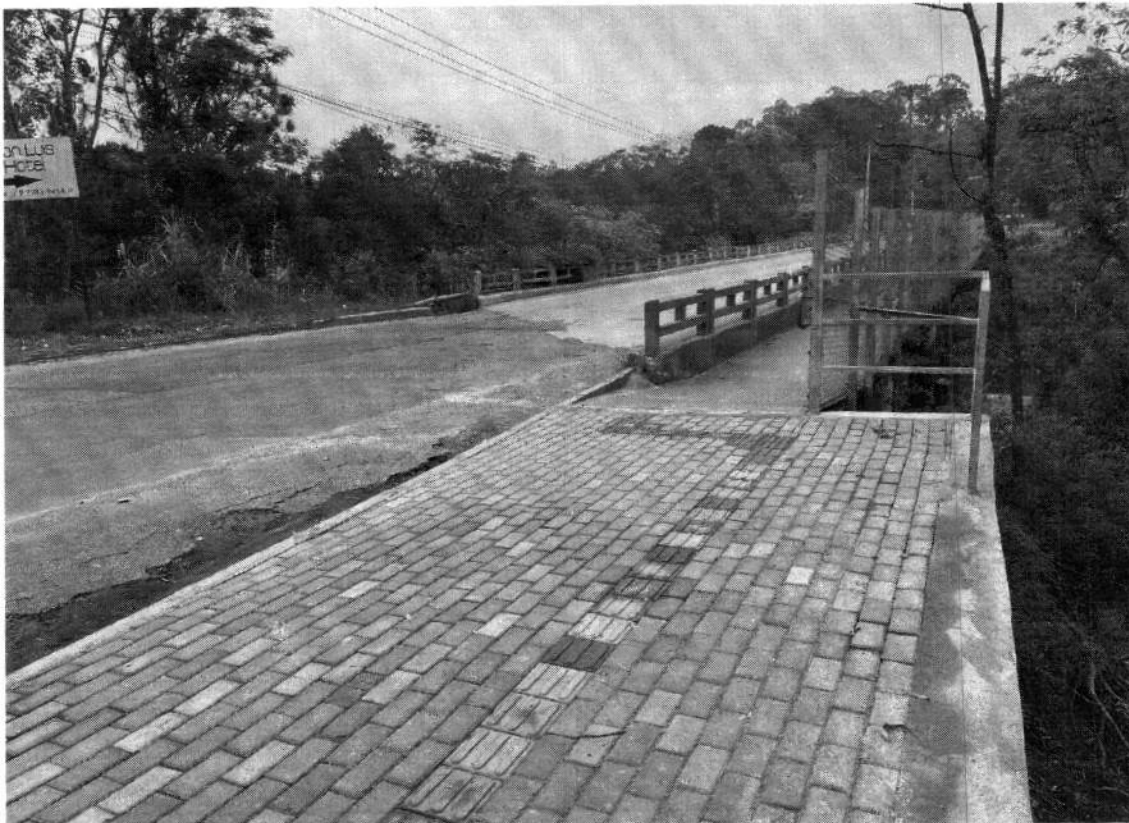
Figura 1 – Foto tirada no dia 03 de outubro de 2023 mostrando a obra com a pavimentação completa
