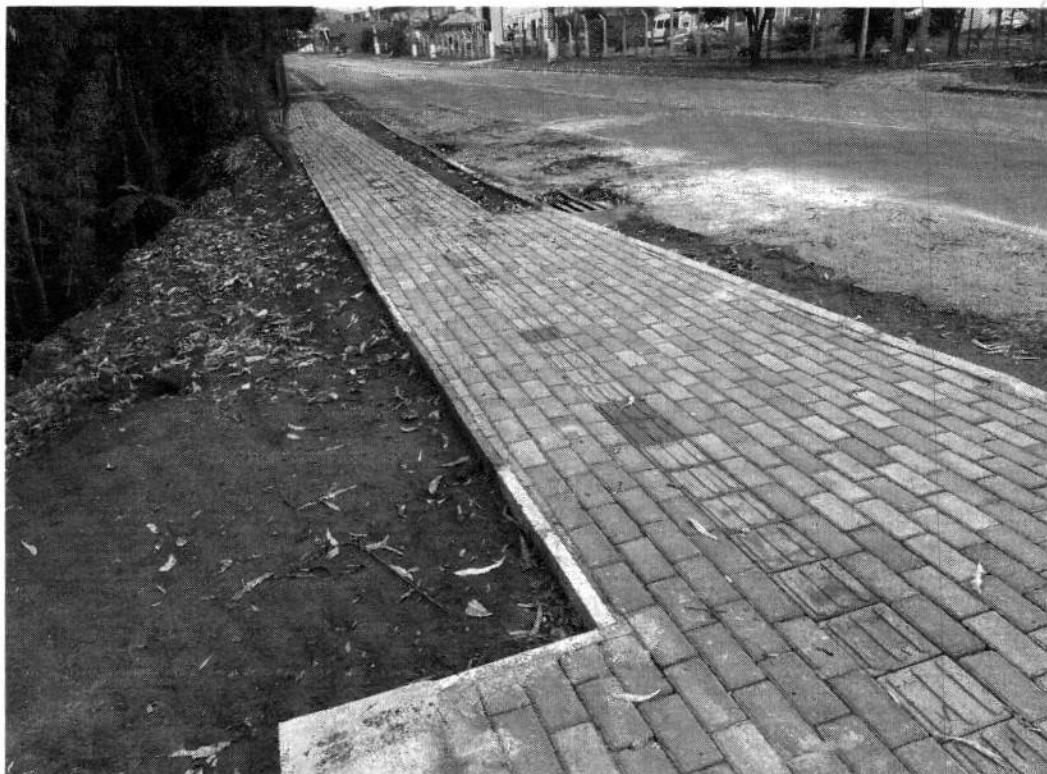
Figura 2 – Foto tirada no dia 03 de outubro mostrando a pavimentação executada.
