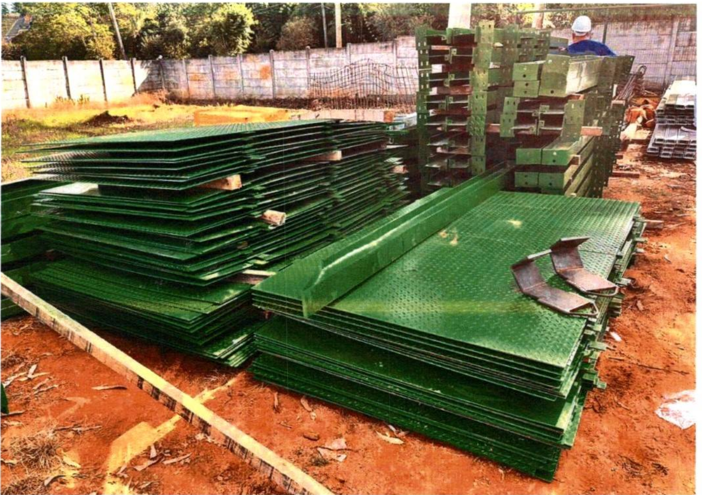
ESTRUTURA METÁLICA RECEBIDA DIA 01/06/2023
