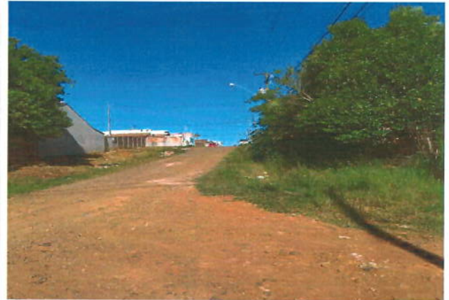
Foto 2 - Rua Pato Branco - T1: Vista geral final da rua, não apresenta meio fio nem outro dispositivo que delimite a caixa da rua.
