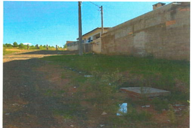
Foto 8 - Rua Guaratuba: Vista de uma caixa de captação de águas pluviais.
