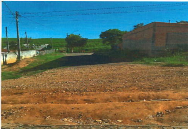
Foto 3 - Avenida Morretes: Vista geral da rua onde se pode verificar na esquina do lado esquerdo encontra-se uma caixa de captação de águas pluviais.
