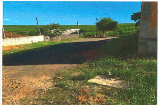
Foto 4 - Avenida Morretes: Vista de 1 caixa de captação de águas pluviais, ausência de delimitação da faixa de rolamento.
