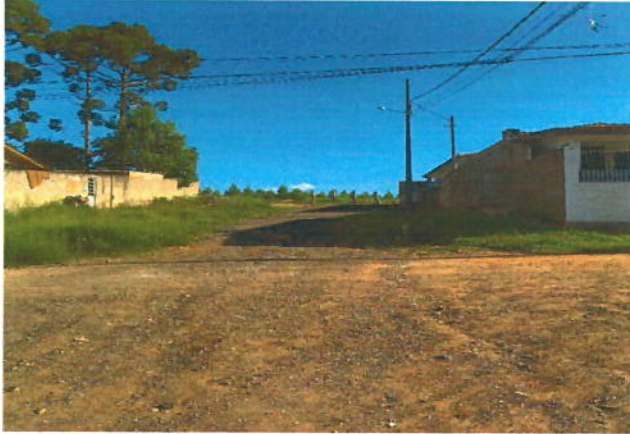
Foto 7 - Rua Guaratuba: Vista geral da rua em leito natural com intervenção de cascalho.
