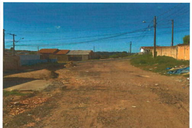
Foto 10 - Rua Itaúna: Caixa de captação de águas pluviais na esquina lado esquerdo.
