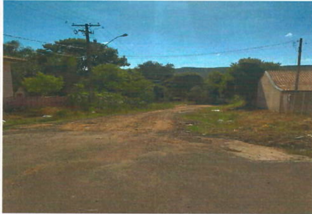
Foto 1 - Rua Pato Branco - T1: Vista geral da rua em leito natural, apresenta 1 caixa de captação de água pluvial.
