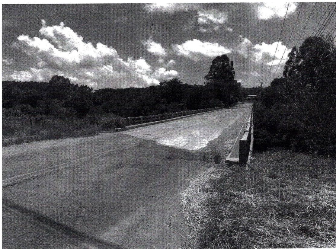
Figura 1: Ponte do Adão, rua Eurides Cunha.
