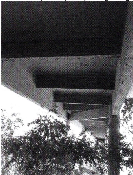
Figura 1 – Mesoestrutura: Sem presença de patologias significantes.
