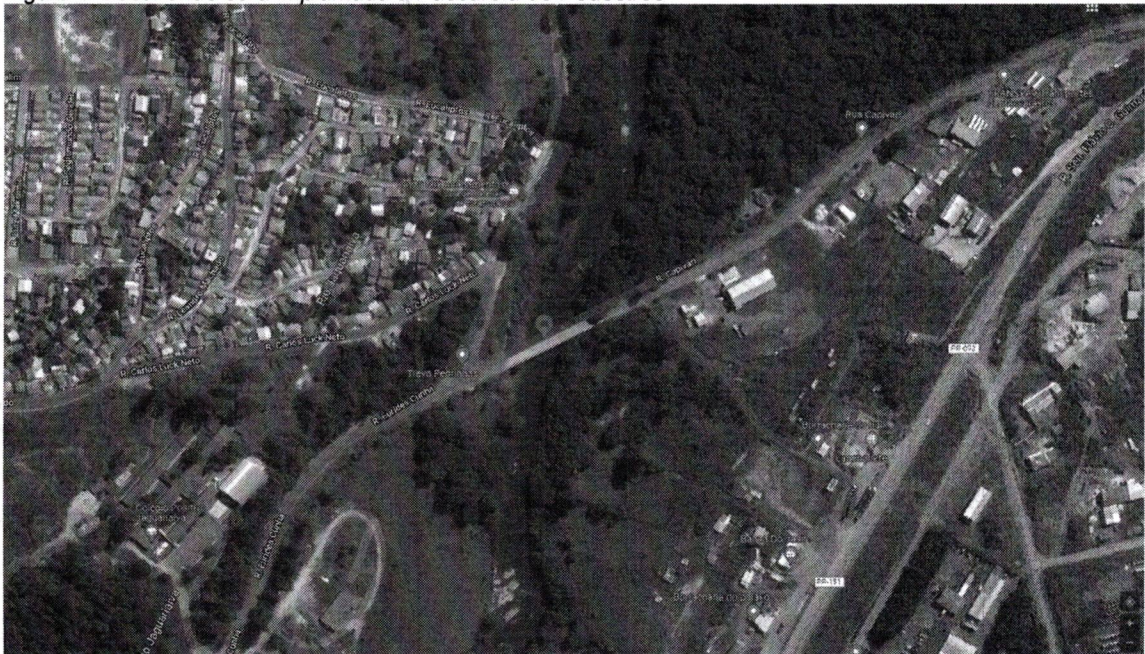
Figura 1: Local onde será implantada a Passarela de Pedestres
