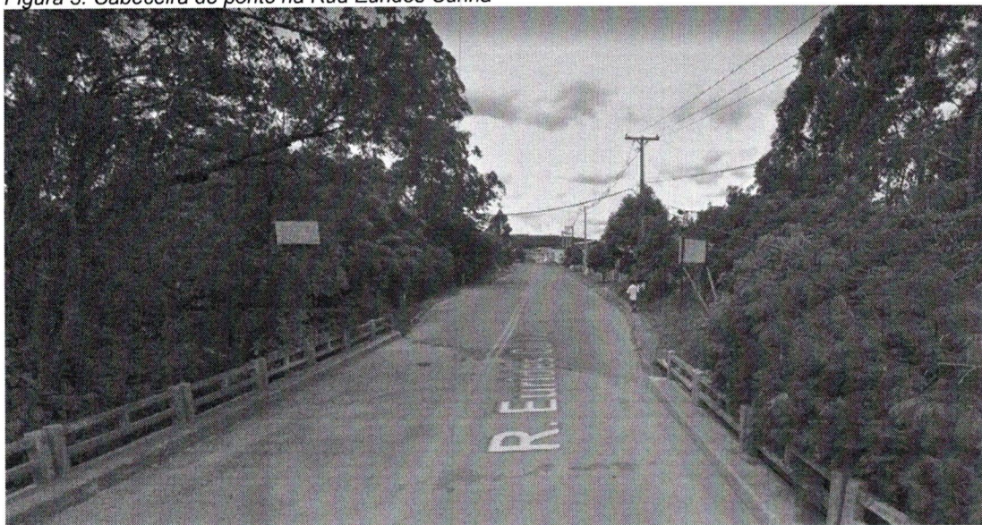
Figura 3: Cabeceira de ponte na Rua Eurides Cunha
