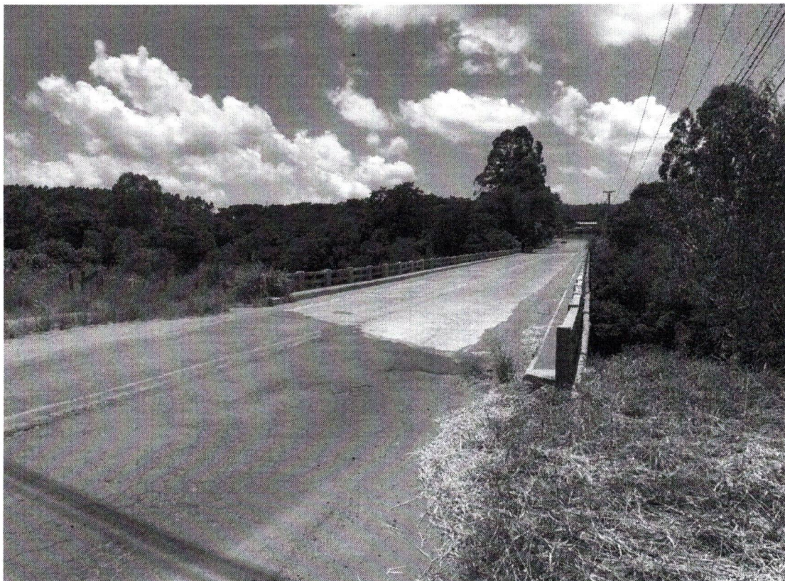
Figura 1: Ponte do Adão, rua Eurides Cunha.
